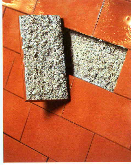
Die keramischen Bodenfliesen werden engfugig in das Mörtelbett eingelegt. Anschließend werden die Fliesen durch mehrmaliges Überfahren mit dem Flächenrüttler angeklopft. Die hohe Vibrationsfrequenz des Rüttlers sorgt für eine kompakte Verdichtung des Bettungsmörtels und lässt die Zementschleimpe in den Fugen aufsteigen.
